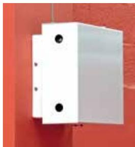
**TRÈS IMPORTANT :** cet enrouleur étant débrayable, nous conseillons fortement de l'installer sur le côté de la salle le long d'un pied de charpente à une hauteur de 3m50. En cas de coupure électrique, la manœuvre pourra s'effectuer sans danger sans nacelle ni échafaudage.
