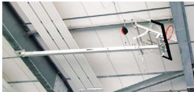
**IMPORTANT :** cette solution n'est pas toujours possible. Il faut en général des fermes très espacées et relativement épaisses en hauteur afin de pouvoir «nicher» le panneau et le cercle. Des renforts de charpente à prévoir au lot charpente sont souvent nécessaires en raison de l'écartement des fermes.
