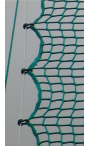
Fixation du câble sur les seconds anneaux haut et bas disponibles, puis tendre avec le tendeur.
